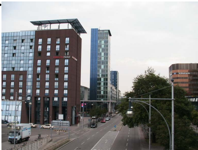
駅舎に続く高層ビルと太陽光パネル
