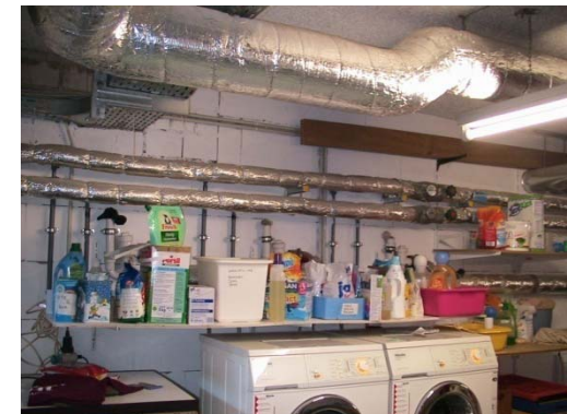
地下1階にある洗濯物乾燥器と断熱処理された集熱パイプ、温水パイプ
