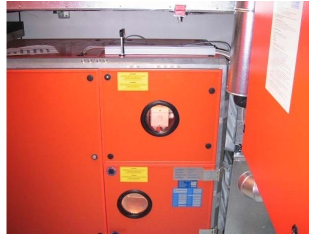
バイオチップペレットの燃焼ボイラー 主に冬季の暖房用
