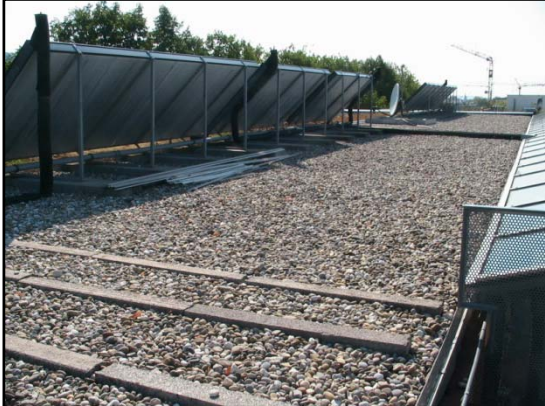
太陽集熱パネルと断熱用の砂利
